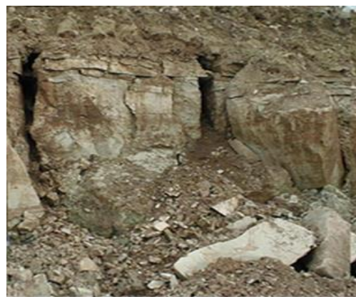
Рисунок 3 – Правый берег Сытыканского водохранилища. Разрез строительного котлована для создания цементно-мерзлотной завесы: а) общий вид стенки строительного котлована, б) детальный снимок участка стенки
