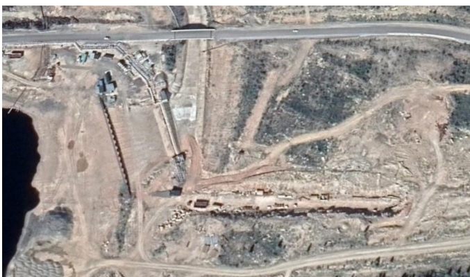
б) строительный котлован
